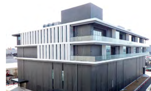
住之江工場生産プロセス開発棟
