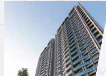
Residential Taiwan, China (Kuensun condominium)
