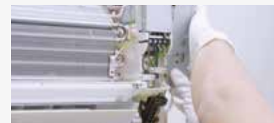
ถอดฝาครอบบอร์ดควบคุม
